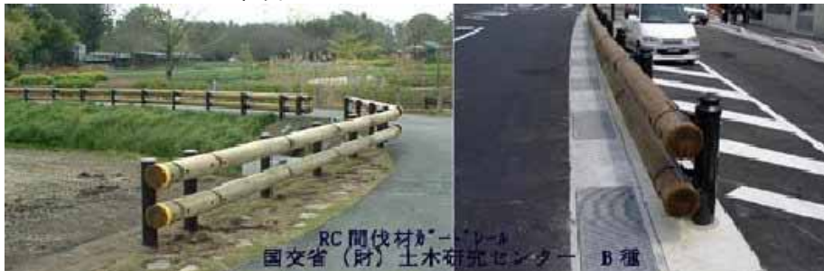
木製ガードレール
