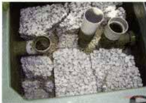
② 浄化用ポラスコンクリートをセット。
